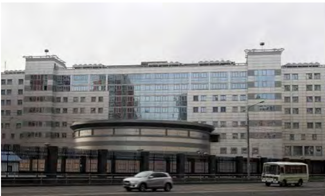
Gebäude des GRU
